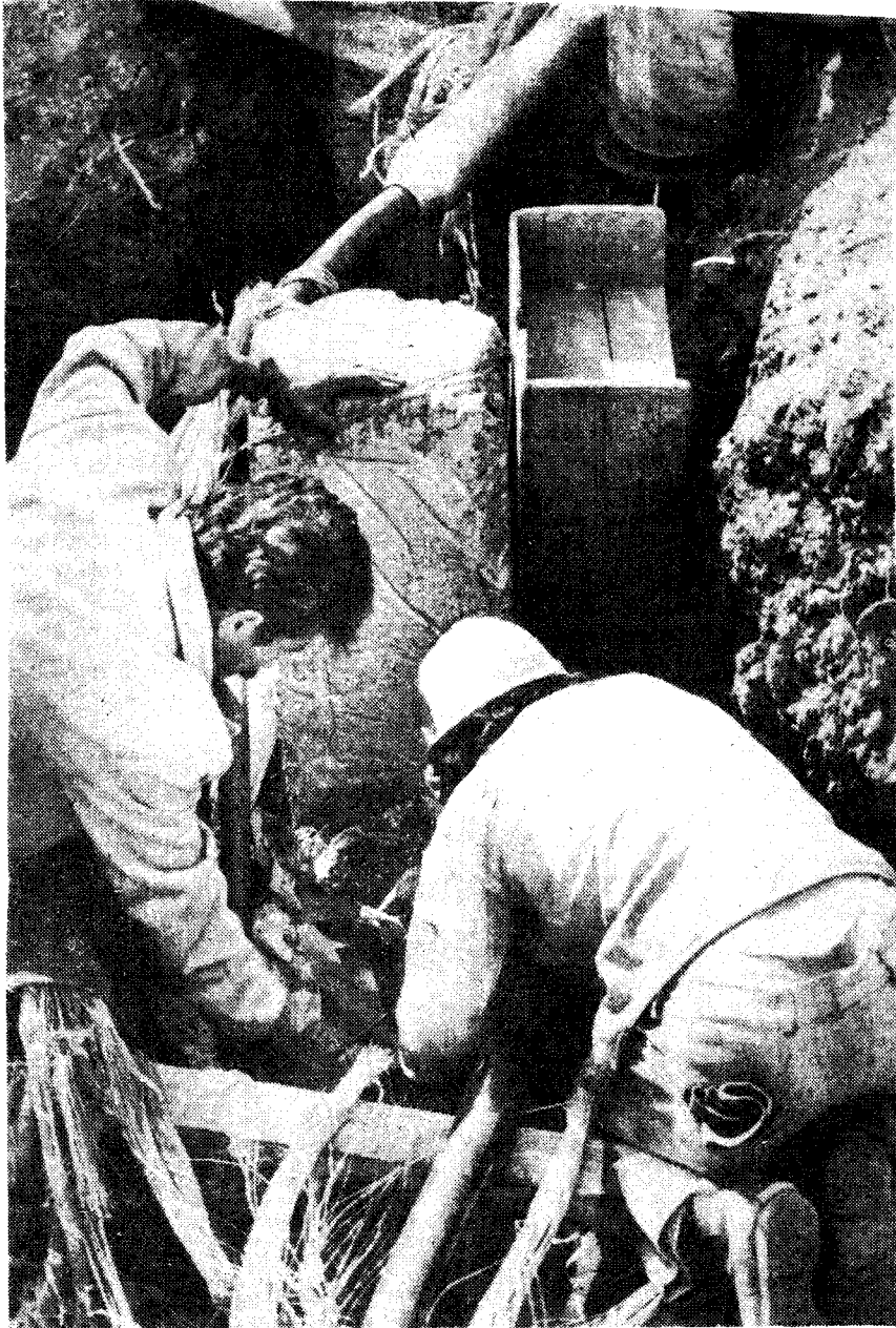
Cuando el invierno aparece, los trabajadores de la Empresa de Teléfonos de Bogotá se dedican a arreglar las líneas afectadas por el agua. 14.000 aparatos quedaron fuera de servicio por el efecto de la naturaleza.
